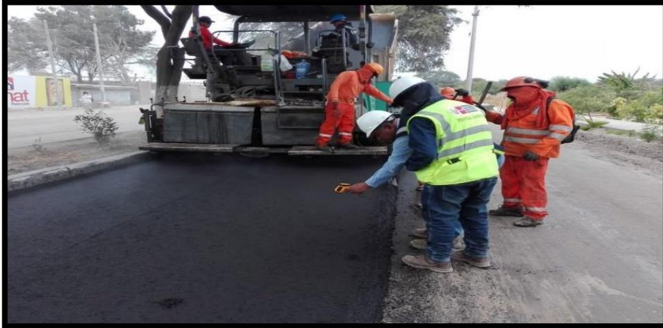
**Figura N° 23:** Construcción de una Carretera – colocación de pavimento asfáltico.
