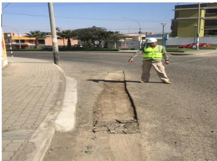
CORTE DE PAVIMENTO Y EXCAVACION EN BERMA
