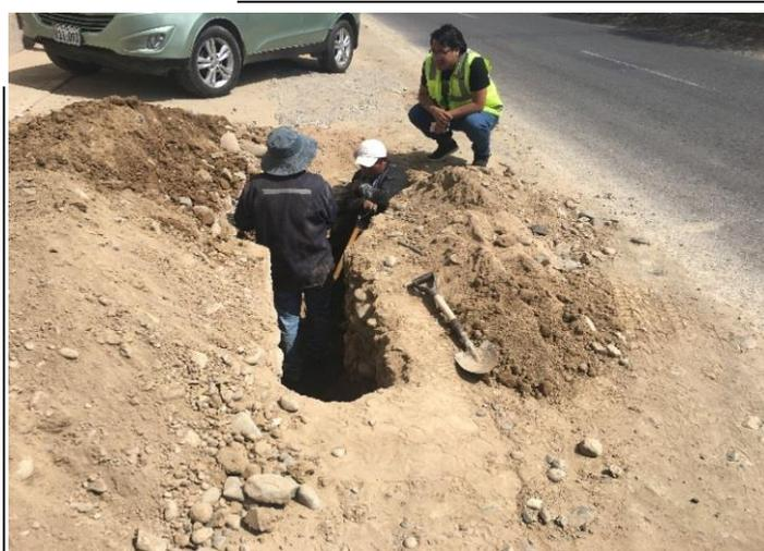
EXCAVACIONES PARA INSTALACION DE TUBERIAS EN BERMA
