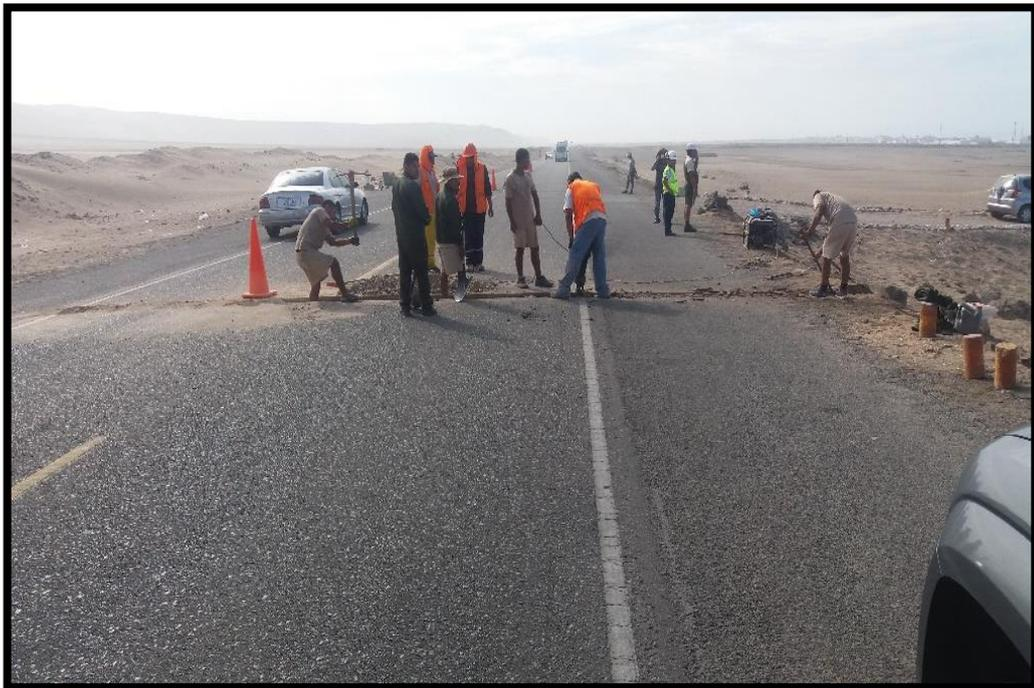
**Figura N° 27:** Daños en la carretera, corte transversal de la calzada, incrementa los costos de operación de vehículos.
