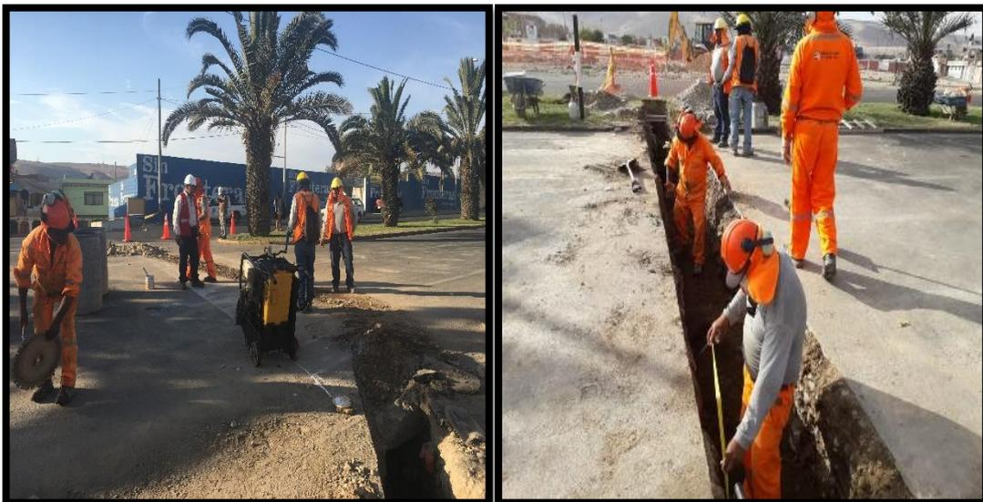
**Figura N° 52:** trabajos de corte y excavación para instalación de servicios básicos en una carretera nacional.
