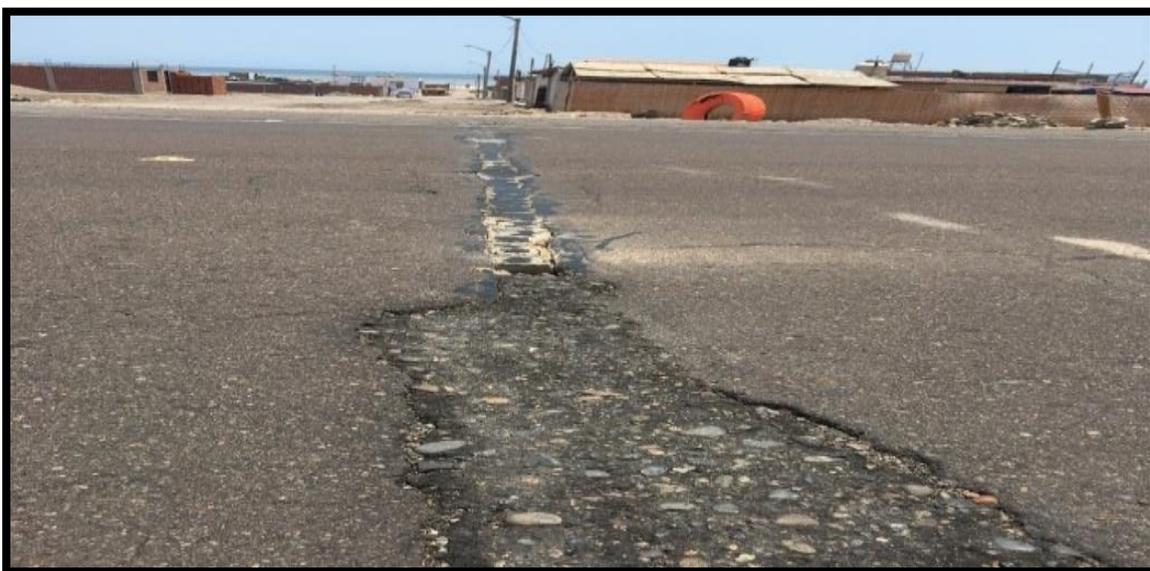
**Figura N° 88:** Corte y Excavación Trasversal para una instalación de servicios de agua
