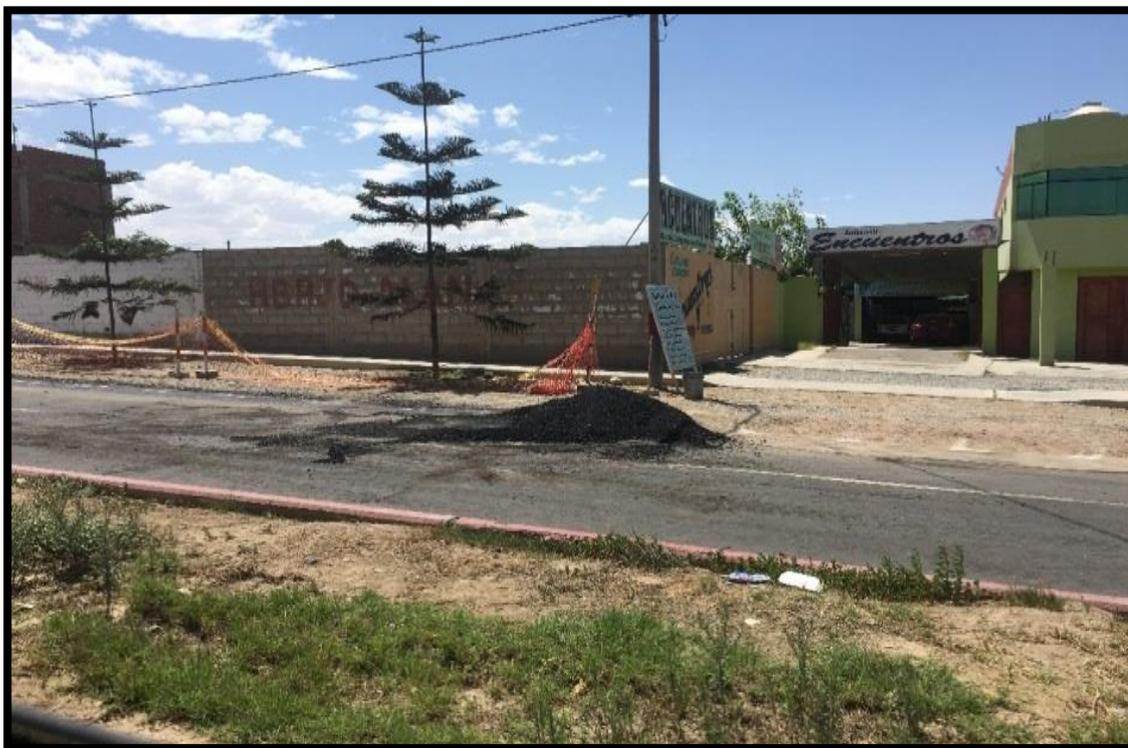
**Figura N° 87:** Reducción de sección transversal en la carretera Nacional por trabajos producto de las invasiones en el derecho de vía.
