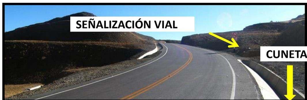
**Figura N° 18:** Estructura de los elementos y características de una vía Nacional dentro de la franja de Derecho de Vía.
