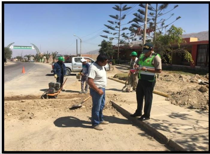
CORTE DE PAVIMENTO Y EXCAVACION EN BERMA
