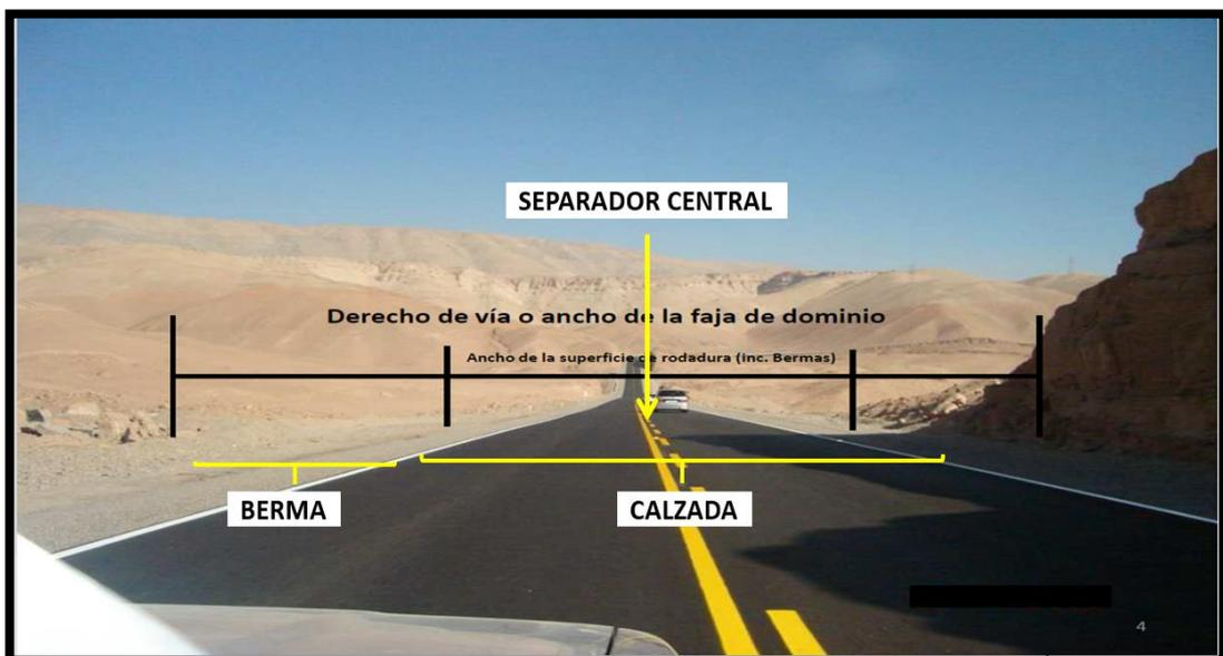
**Figura N° 31:** Elementos que componen el derecho de vía de una carretera.
