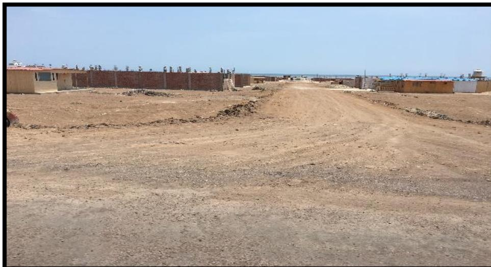
**Figura N° 86:** Proliferación de accesos no autorizados, instalados a lo largo de la carretera: PE-1SD, Tramo: Tacna- Ilo
