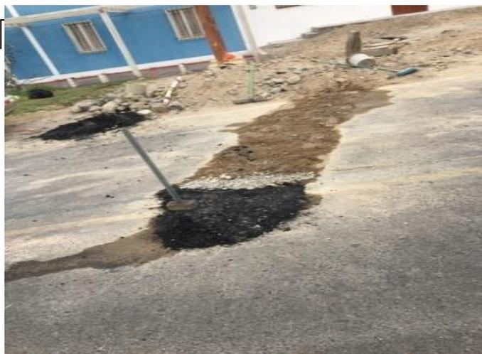
CORTE DE PAVIMENTO Y EXCAVACION EN BERMA
