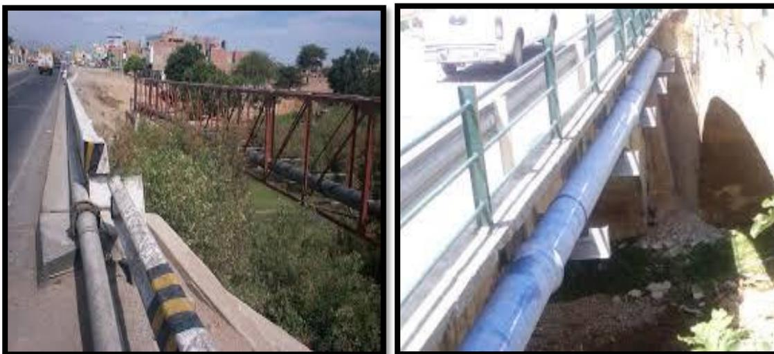
**Figura N° 50:** Tubería de servicios básicos adosados en un puente, la cual está prohibido, estos elementos deben tener su propia estructura independiente al puente.
