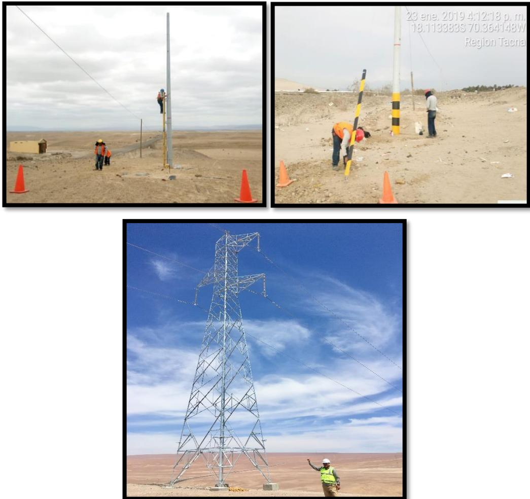
**Figura N° 53:** Trabajos de instalación de postes para el tendido de fibra óptica y energía eléctrica de alta tensión con cruce aéreo dentro del Derecho de Vía.
