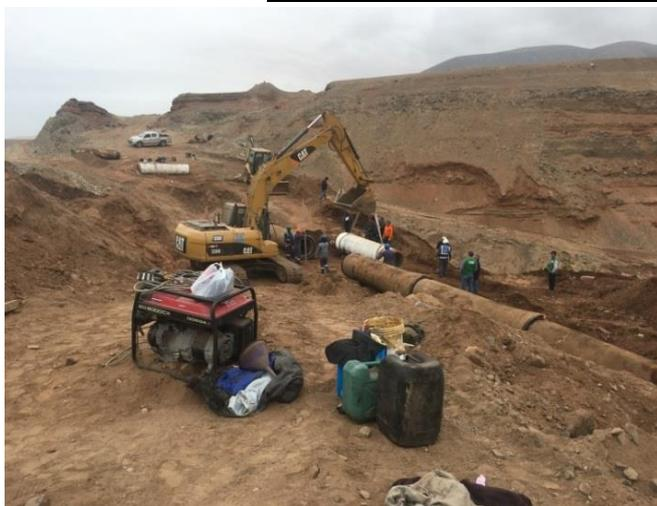
ROTURA DE TUBERIA DE AGUA DE 32" POR PARTE DE EPS-ILO
