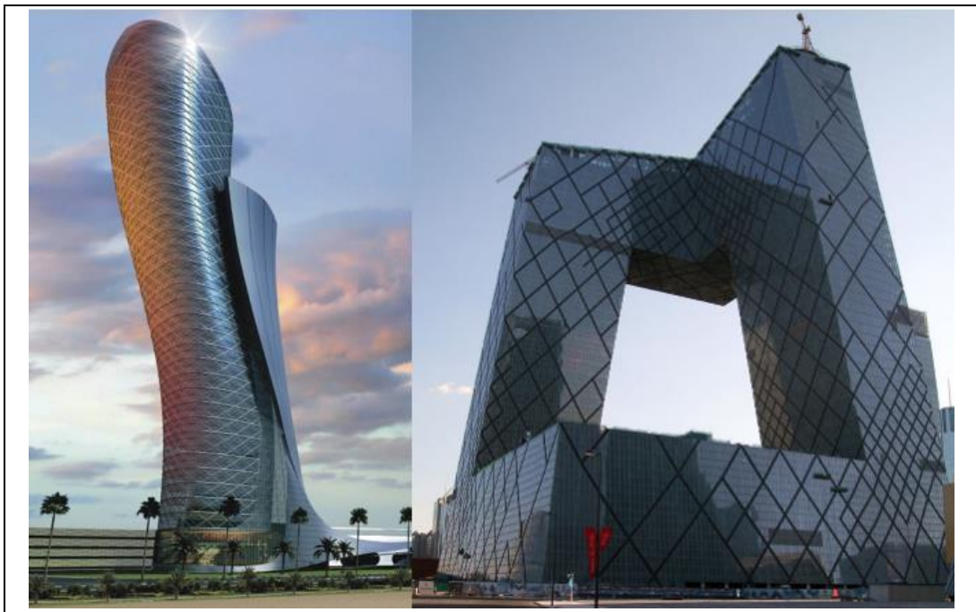
Figura 4.12: Edificios Diagrid que desafían la gravedad. Fuente: foto izquierda, foto derecha https://es.wikipedia.org/wiki/Sede_de_la_Televisi%C3%B3n_Central_de_China
