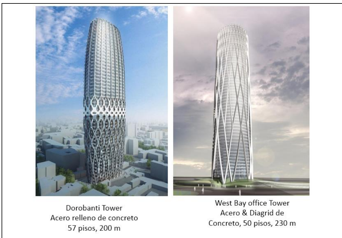
Figura 4.9: Edificios Diagrid con materiales mixtos. Fuente: foto izquierda
