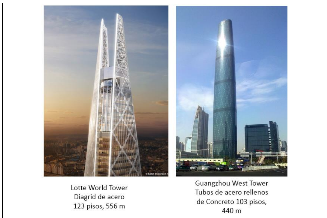
Figura 4.7: dos edificios Diagrid Altos (Diagrid de acero y tubos rellenos). Fuente: foto izquierda https://es.wikipedia.org/wiki/Lotte_World_Tower , foto derecha https://es.wikipedia.org/wiki/Guangzhou_International_Finance_Center .
