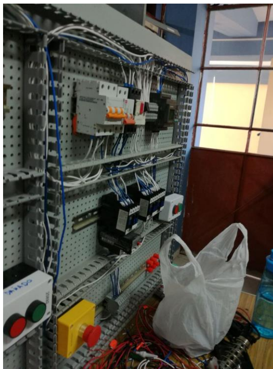
Figura 64: Módulo en construcción (fuente: propia)
