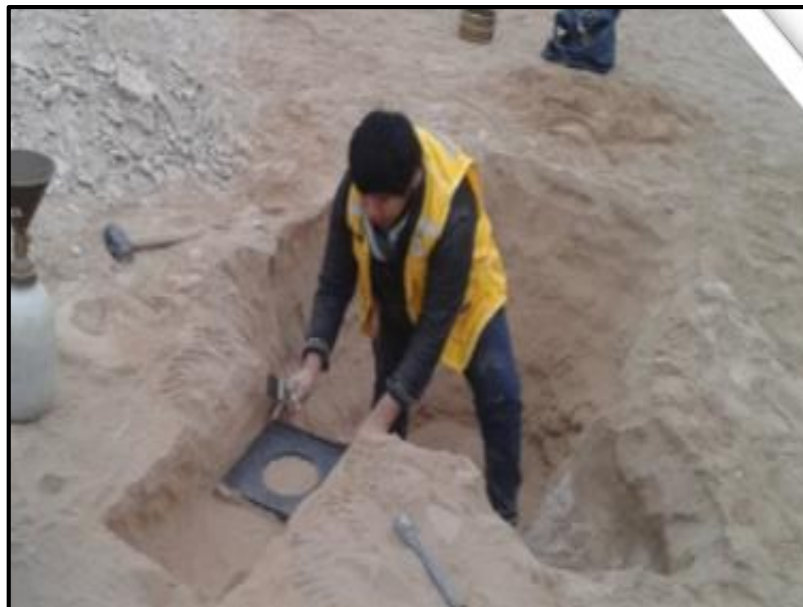
Figura 37. Calicata C-8, suelo SM, prof. 0.8m
