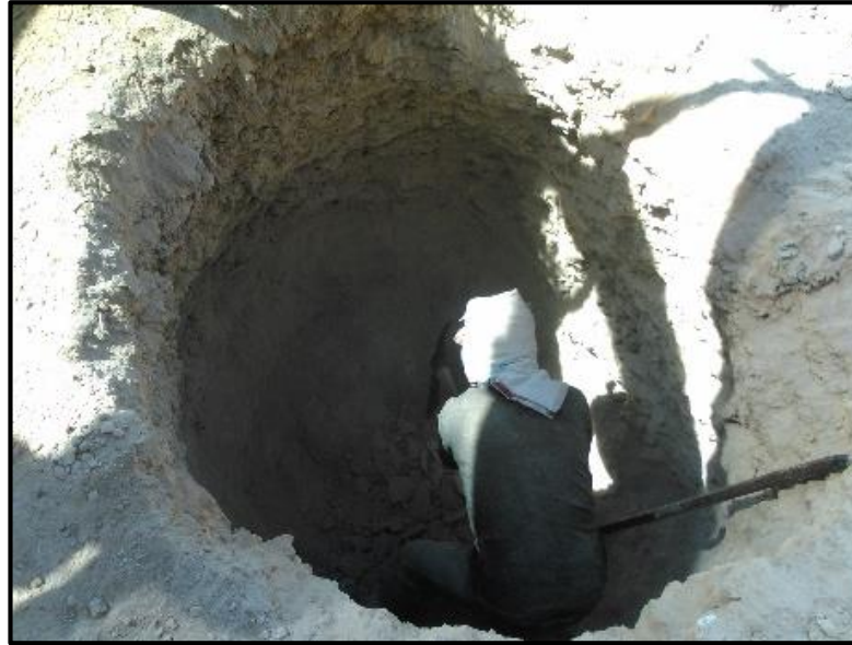
Figura 34. Calicata C-5, suelo SM, prof. 1.2m observa afloramiento rocoso
