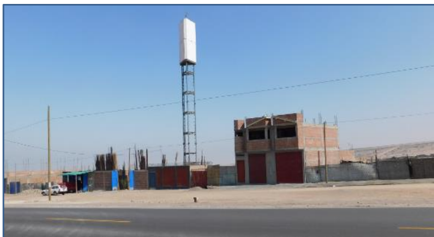
Figura 5. Viviendas construidas en las Asociaciones Pecuarias
