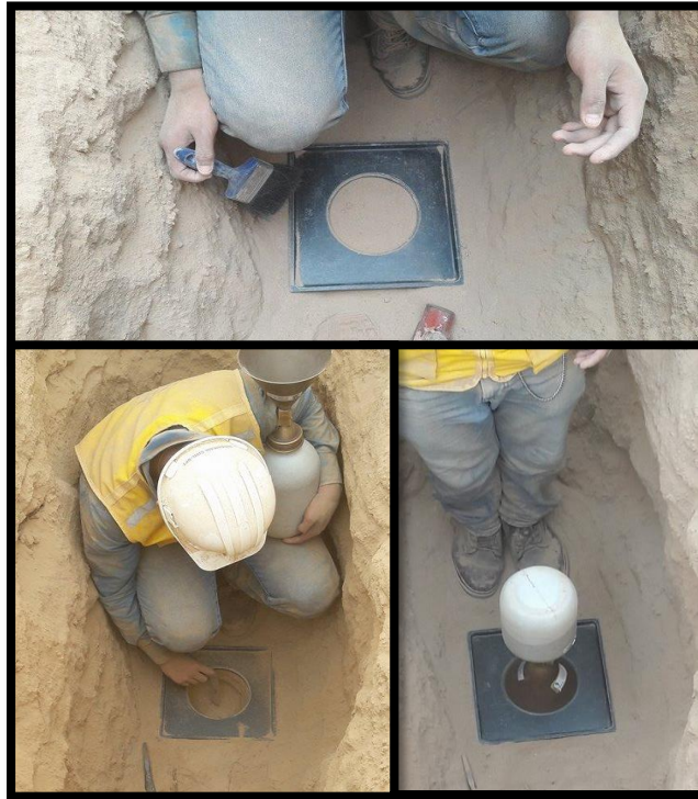
Figura 39. Ensayo de Densidad In situ, calicata C-1
