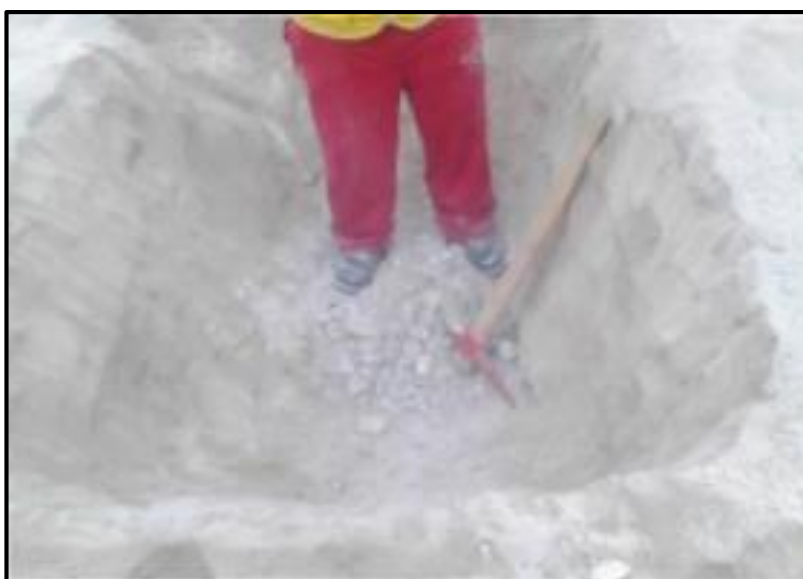
Figura 31. Calicata C-2, suelo SM, prof.0.8m
