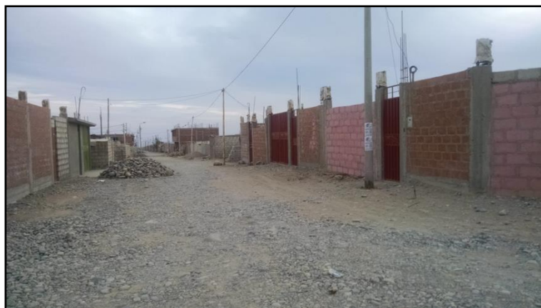
IMAGEN 03: Se observa la calle 06 de la Asociación San Carlos.
