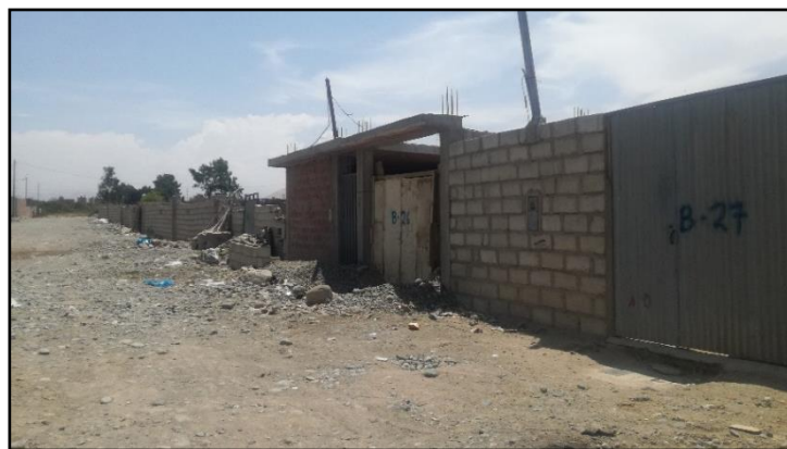
IMAGEN 17: Se observa la manzana “B”, donde la vivienda B – 26 y B – 27 están construidas perimetralmente.
