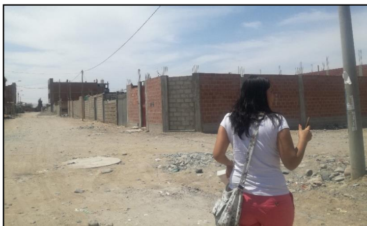
IMAGEN 20: Se observa la manzana “A”, donde las viviendas de la manzana se encuentran construidas perimetralmente y algunas provisionalmente.
