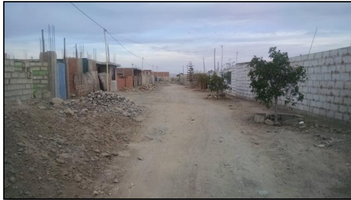
IMAGEN 12: Se observa que las calles no se encuentran asfaltadas.
