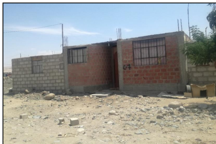
IMAGEN 14: Se observa la manzana "C", donde la vivienda C - 07 está construida en un solo nivel.
