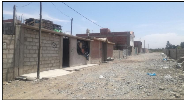
IMAGEN 16: Se observa la manzana “C”, donde la vivienda C – 01 y C - 02 se encuentran en un solo nivel y su vía no se encuentra asfaltada.
