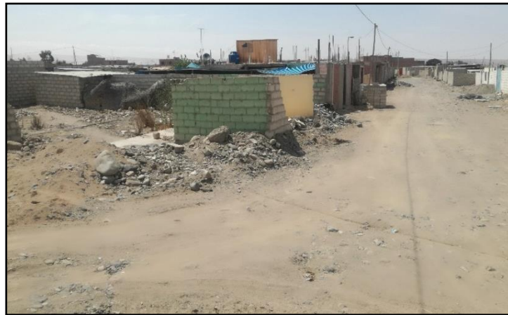
IMAGEN 07: Se observa la manzana "H", donde se observa la calle que no se encuentra asfaltada.
