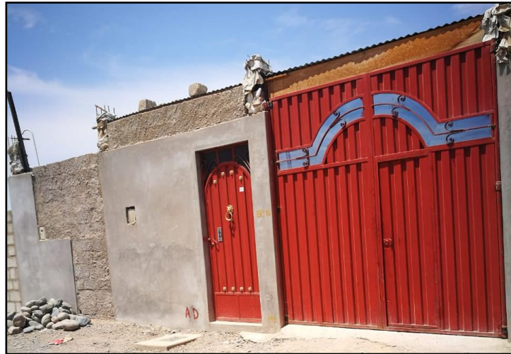
IMAGEN 06: Se observa la manzana "C", donde la vivienda C - 2 está construida en un solo nivel.
