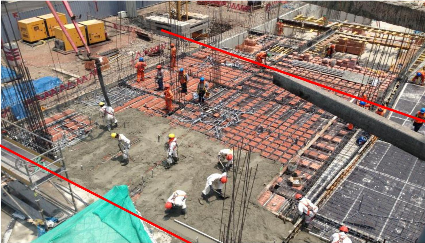
*Figura 57: Corte de Vaciado según sectorización. Fuente: Elaboración Propia*
