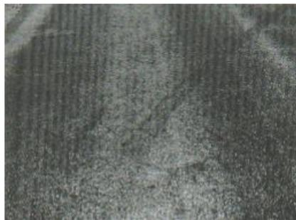
*Figura 7.* Exudación de baja severidad.
