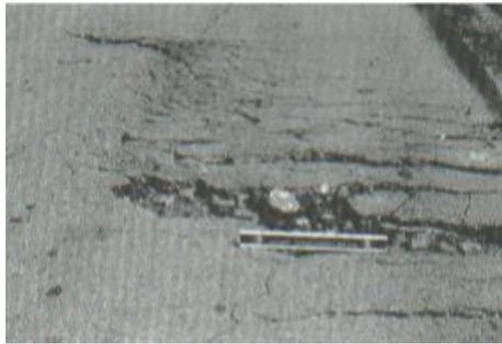
*Figura 52.* Grieta parabólica (slippage) de alta severidad.
