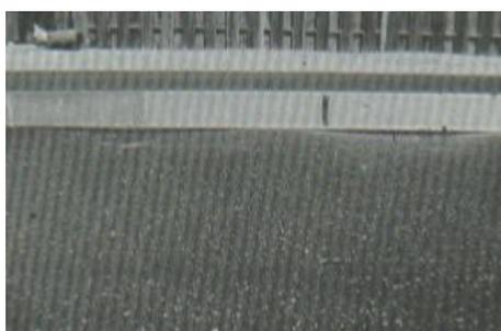
*Figura 17.* Corrugación de severidad media.
