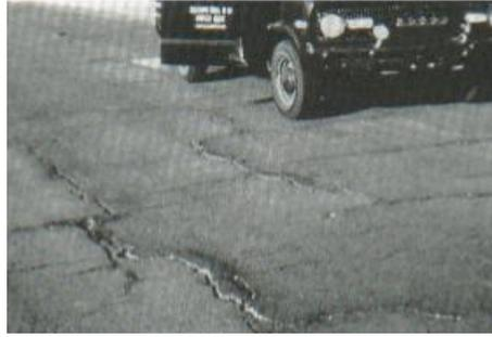
*Figura 12.* Grietas en bloque de alta severidad.
