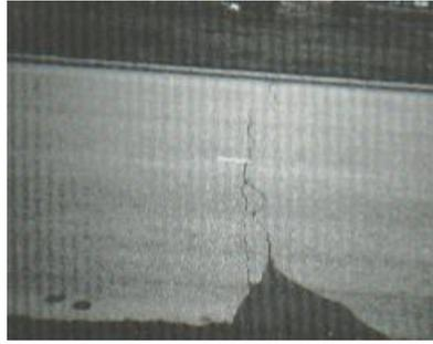
*Figura 32.* Grietas longitudinales y transversales (No PCC) de severidad media.
