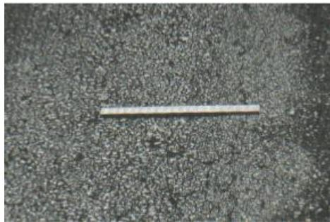
*Figura 54.* Meteorización / desprendimiento de agregados de baja severidad.
