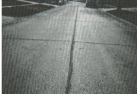
*Figura 25.* Grieta de reflexión de junta de baja severidad.
