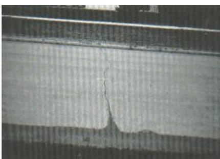
*Figura 31.* Grietas longitudinales y transversales (No PCC) de baja severidad.
