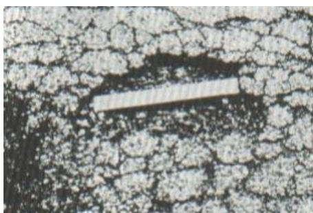
*Figura 38.* Hueco de baja severidad.
