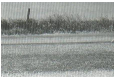
*Figura 16.* Corrugación de baja severidad.
