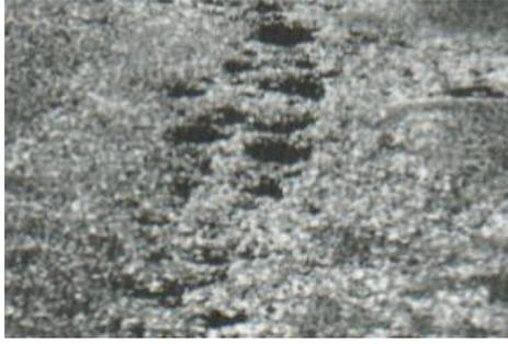
*Figura 56.* Meteorización / desprendimiento de agregados de alta severidad.
