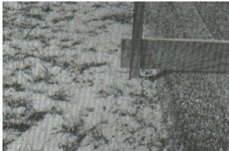
*Figura 28.* Desnivel carril / berma de baja severidad.
