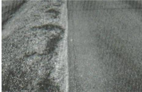
*Figura 22.* Grieta de borde de baja severidad.
