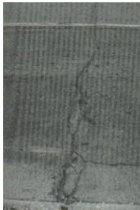
*Figura 26.* Grieta de reflexión de junta de severidad media.
