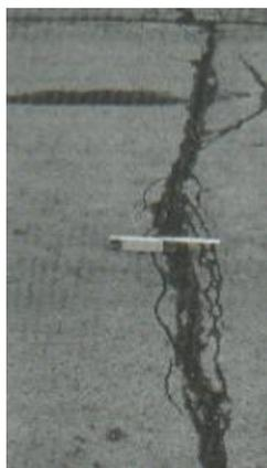
*Figura 27.* Grieta de reflexión de junta de alta severidad.
