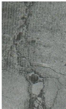
*Figura 33.* Grietas longitudinales y transversales (No PCC) de alta severidad.
