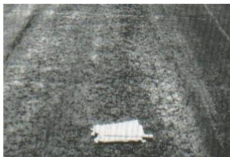
*Figura 55.* Meteorización / desprendimiento de agregados de severidad media.
