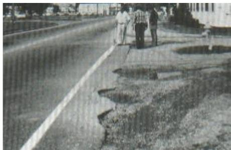
*Figura 24.* Grieta de borde de alta severidad.
