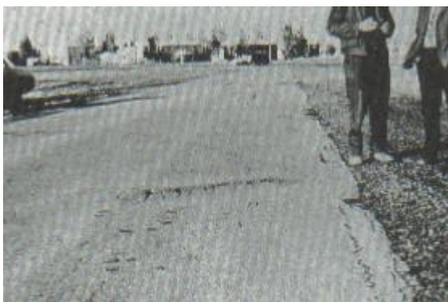
*Figura 14.* Abultamientos y hundimientos de severidad media.
