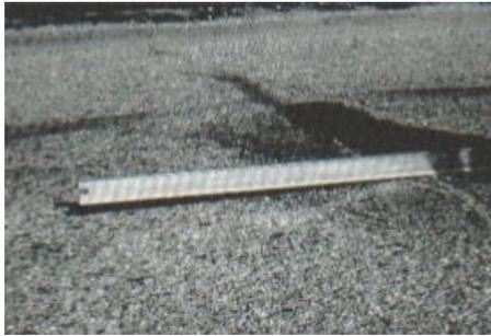
*Figura 13.* Abultamientos y hundimientos de baja severidad.
