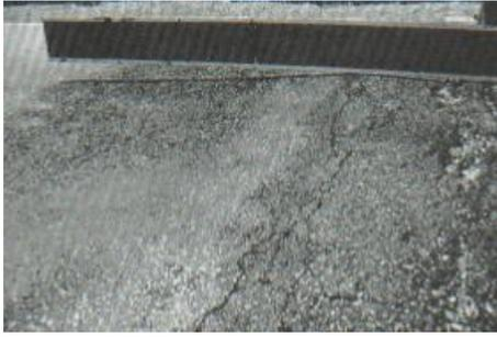
*Figura 15.* Abultamientos y hundimientos de alta severidad.
