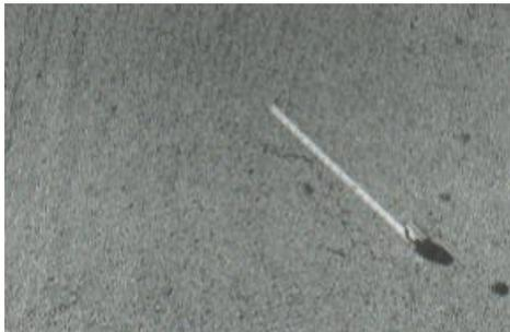
*Figura 50.* Grieta parabólica (slippage) de baja severidad.
