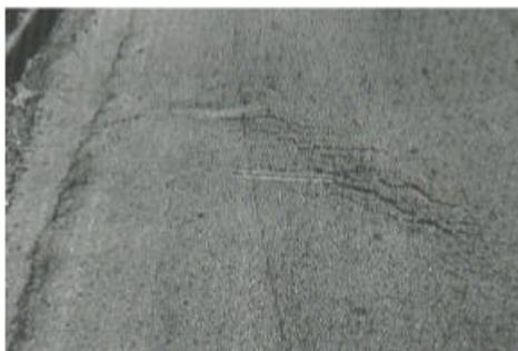
*Figura 51.* Grieta parabólica (slippage) de severidad media.
