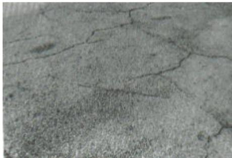
*Figura 10.* Grietas en bloque de baja severidad.
