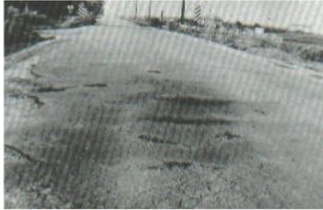
*Figura 48.* Desplazamiento de severidad media.
