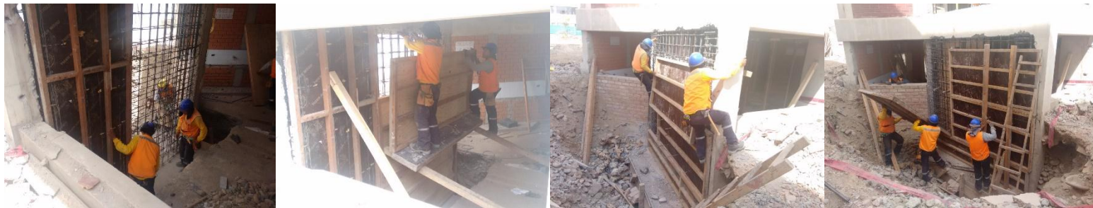
Gráfico 49. Anexo Carta Balance – Proyecto 01/Encofrado/01 Fuente: Elaboración propia
