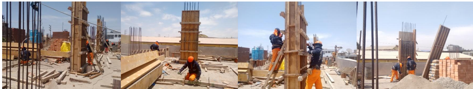
Gráfico 62. Anexo Carta Balance – Proyecto 03/Encofrado/01 Fuente: Elaboración propia
