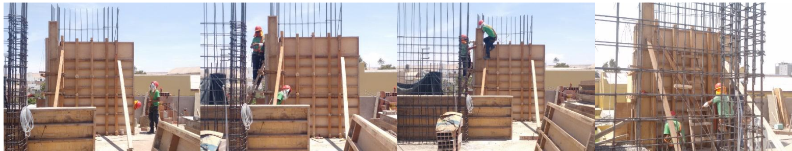
Gráfico 63. Anexo Carta Balance – Proyecto 02/Encofrado/02 Fuente: Elaboración propia
