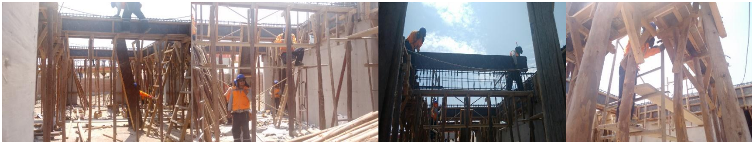
Gráfico 55. Anexo Carta Balance – Proyecto 02/Encofrado/01 Fuente: Elaboración propia
