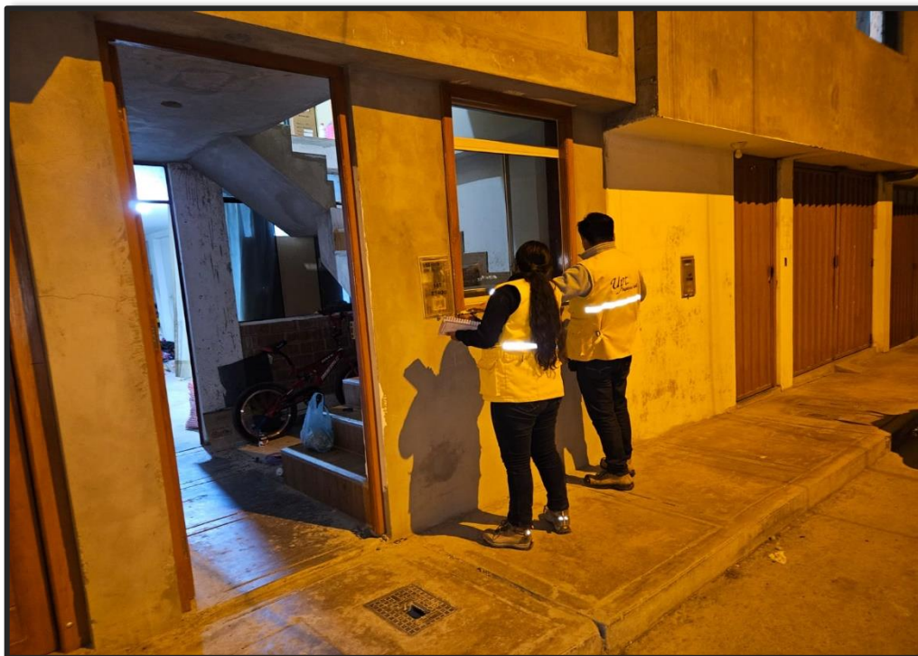
Fotografía 03. Se realizo el levantamiento de información de la vivienda unifamiliar construida con el programa Techo Propio. Distancias de ventanas bajas
