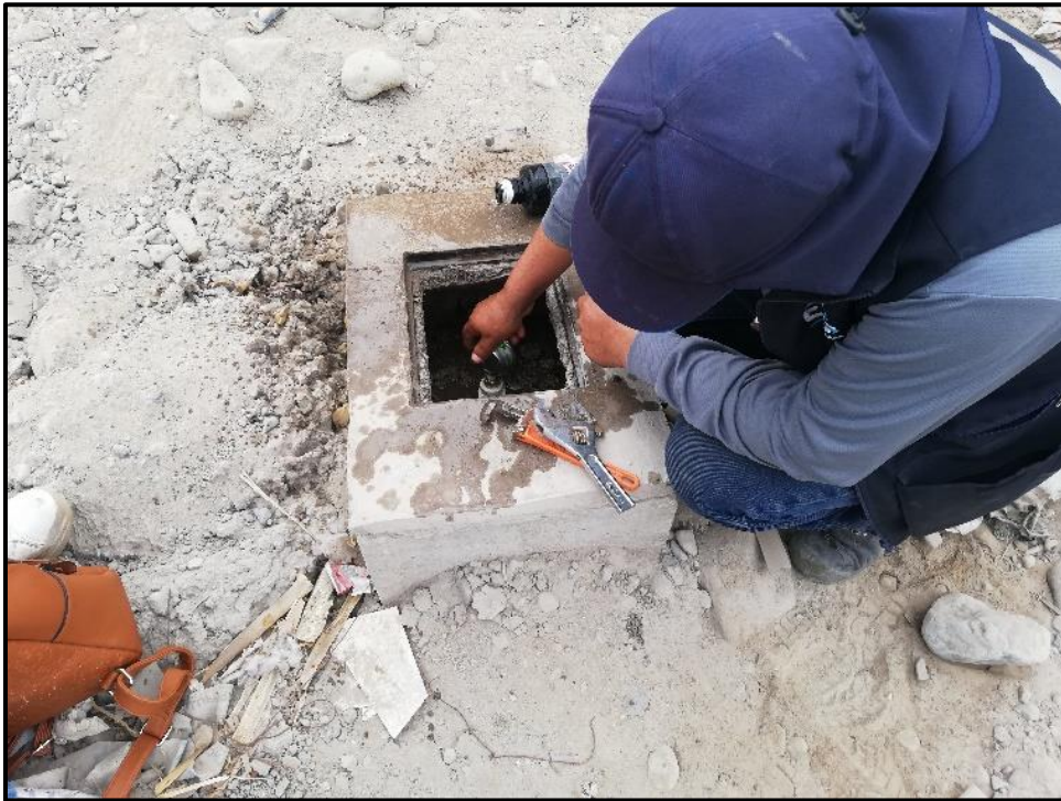
Foto 3: Toma de presión en la Av. Villauta
