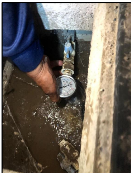
Foto 6: Toma de presión en las redes de distribución del Sector Sobraya (zona alta) a las 6:30pm
