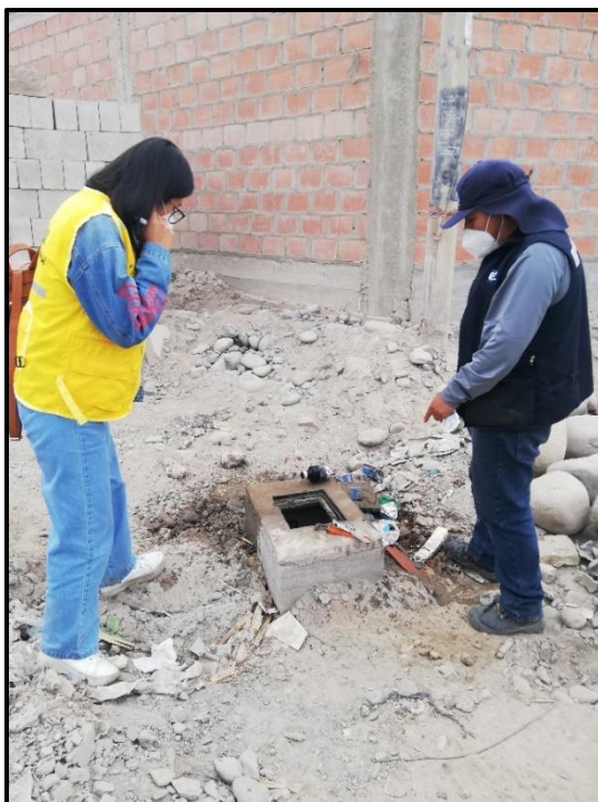
Foto 2: Toma de presión en la Av. Villauta
