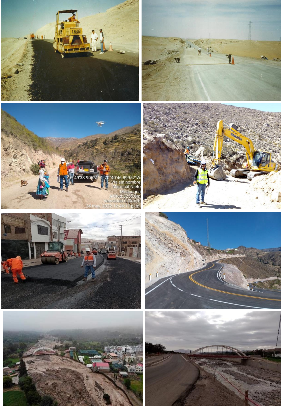
Figura 34 Supervisión y Control de Calidad en construcción de la Infraestructura Vial
