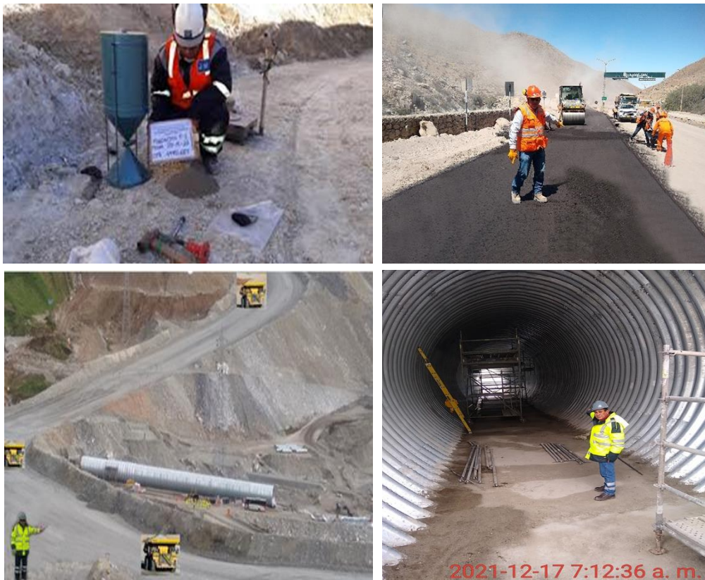
Figura 33 Supervisión y Control de Calidad en construcción de la Infraestructura Vial
