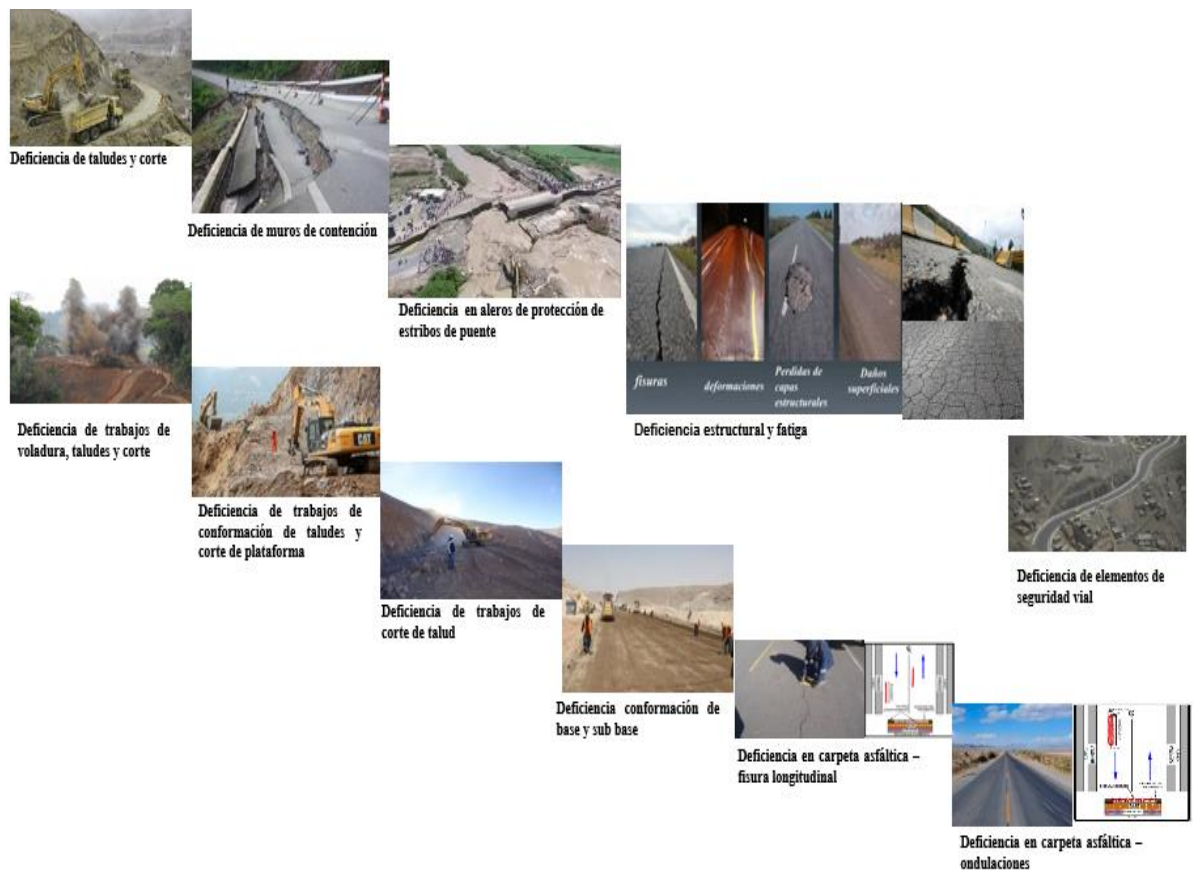
Figura 10 Evaluación de parámetros que se consiguen con un control de calidad en proceso constructivo de las carreteras e infraestructura vial.
