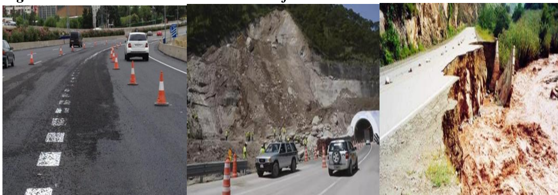
Figura 31 Calidad en construcción de la Infraestructura Vial
