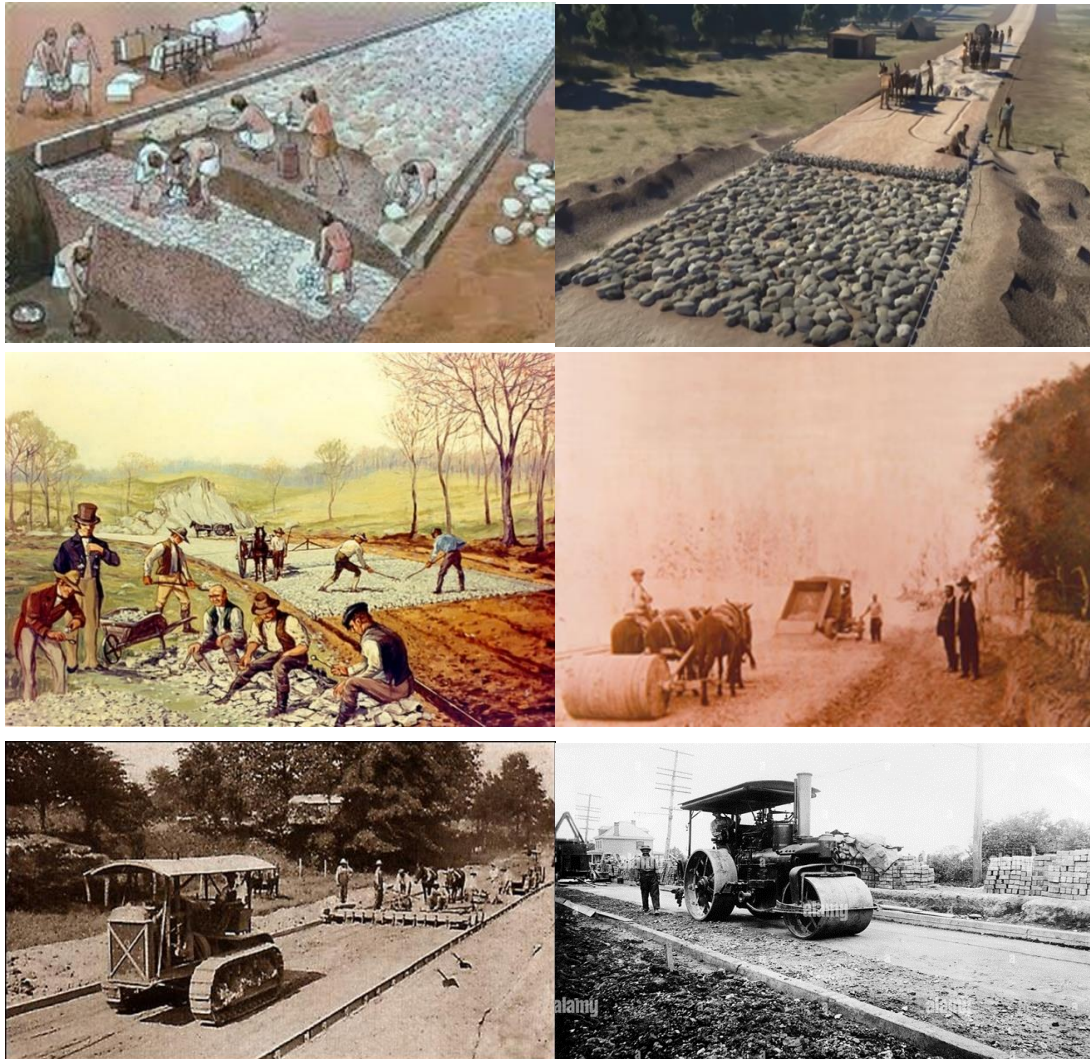
Figura 2 El control de calidad de los procedimientos constructivos en la industria de la construcción de carreteras
