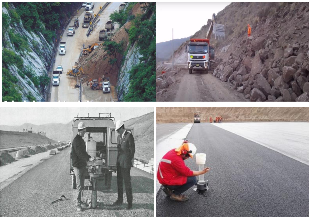
Figura 29 Control de la calidad en proceso constructivo de un Proyecto
