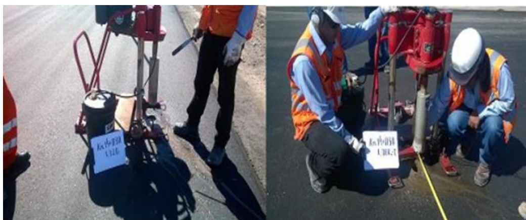
Figura 20 Control de calidad en proceso constructivo
