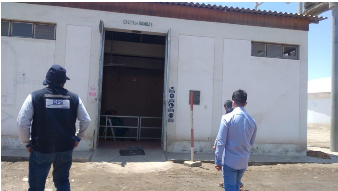
Fotográfica 4: Evaluación de Infraestructura del R – 11, 13 y la Estación de Bombeo Nº 2
