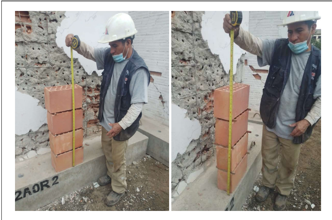
Verificación de espesor de junta para la construcción de las pilas de albañilería
