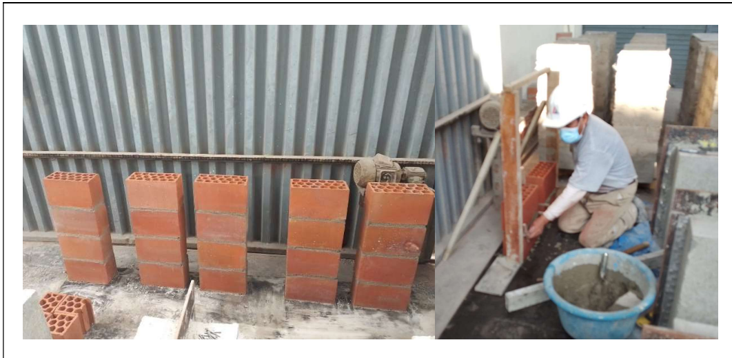
Construcción de las pilas de albañilería
