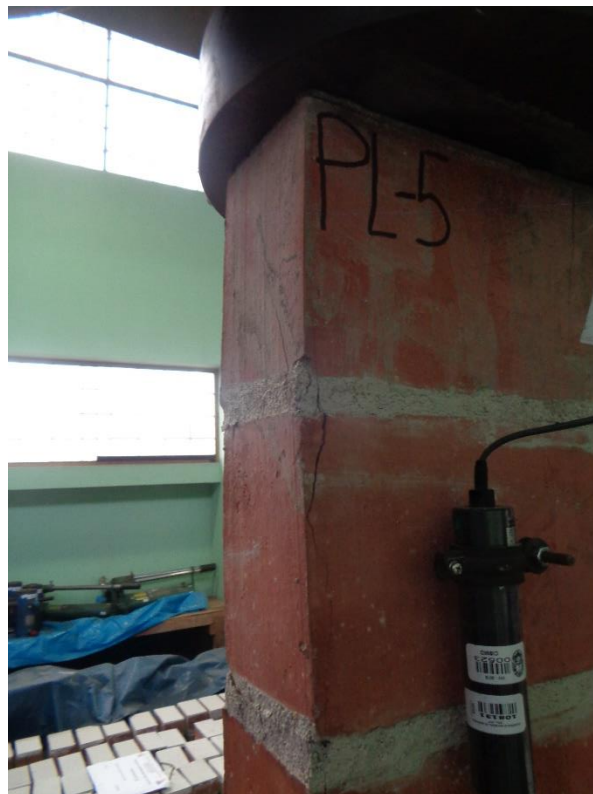
Foto 6. Pila PL-5, grietas en esquinas en la zona superior
