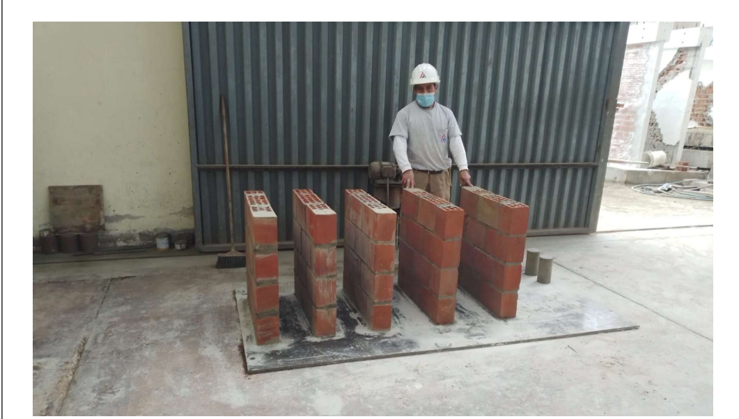
Construcción de muretes de albañilería
