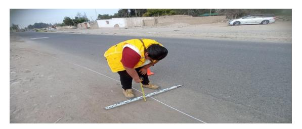
Nota. En la figura se muestra el reconocimiento en campo de un hundimiento en la calzada de la avenida Los Ángeles. Con ayuda de la regla de aluminio y la wincha se mide la profundidad del hundimiento ubicado en el carril derecho del tramo de subida.
