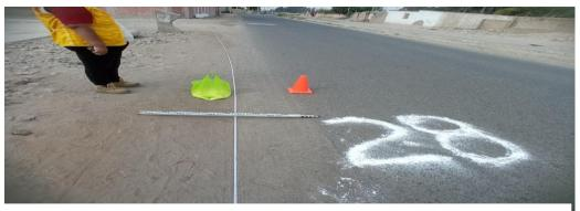
Nota. En la figura se muestra el marcado con yeso en la vía, para la correcta identificación de la unidad de muestra a inspeccionar.
