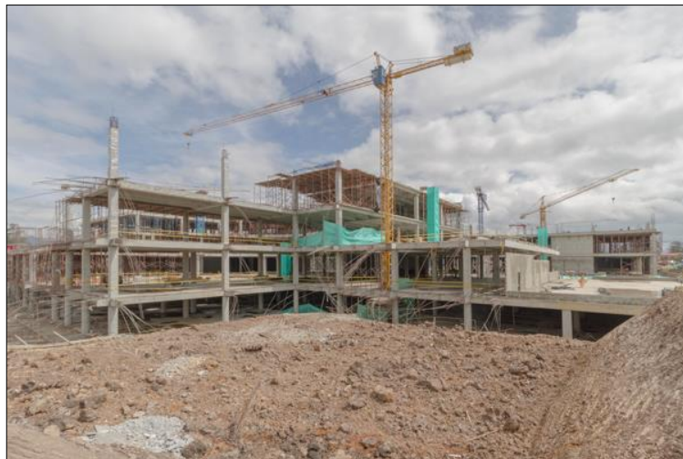
Figura 3 Sistema de pórticos
