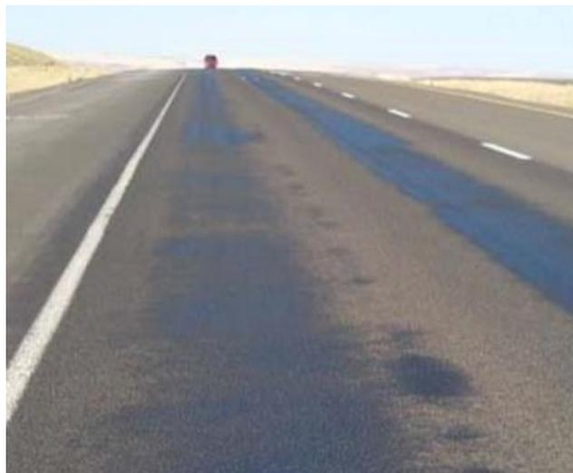
*Nota.* Afloramiento del exceso de asfalto.
