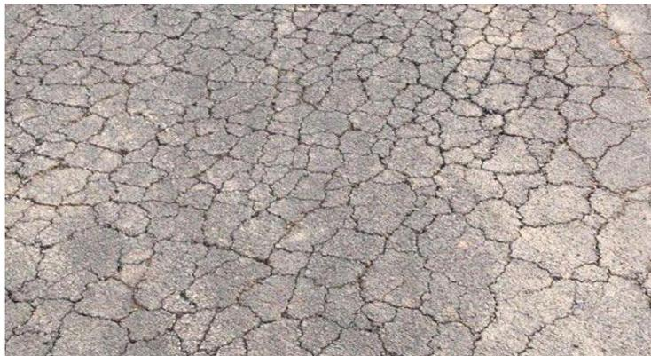
*Nota.* En la imagen se puede apreciar las fisuras interconectadas de la piel de cocodrilo
