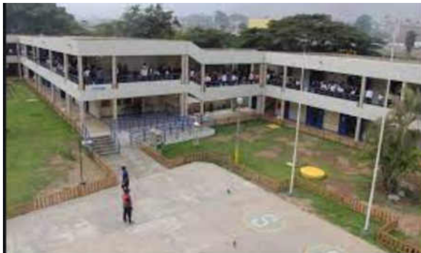
Imagen 04: Vista pabellones CMSPP, fuente Minedu
