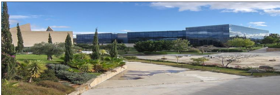
IMAGEN N°05: Vista zona de servicios generales del Inst. Agroindustrial de Meta
