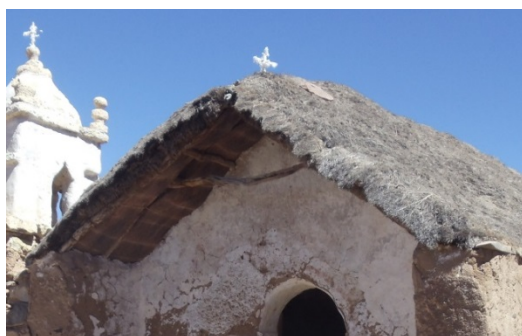
Vista en perspectiva de la techumbre con la que se cierra el arco cobijo. Se observa su capa externa de ichu quemada por el clima.
