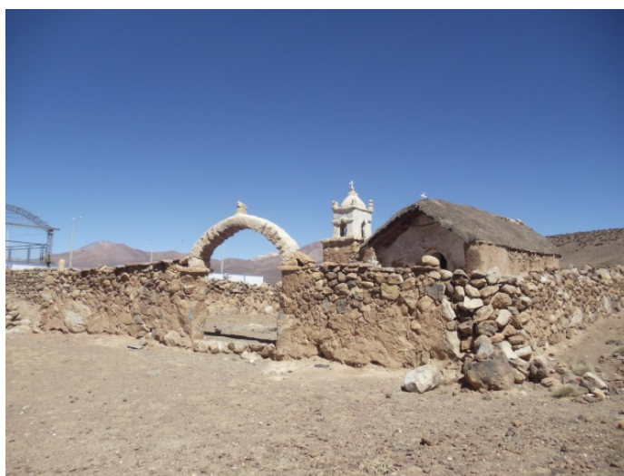
Vista eterna desde la plaza donde se observa el cerco y en medio el arco de ingreso al atrio de la capilla.
