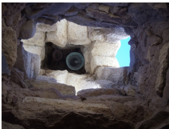
Vistas del interior del campanario en el que se observa su estructura y las campanas.
