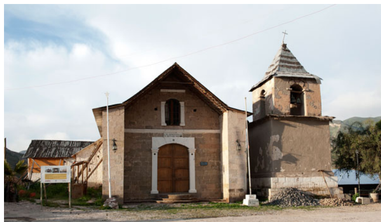
Templo de San Francisco de Asís, Socoroma, previo a su restauración.
