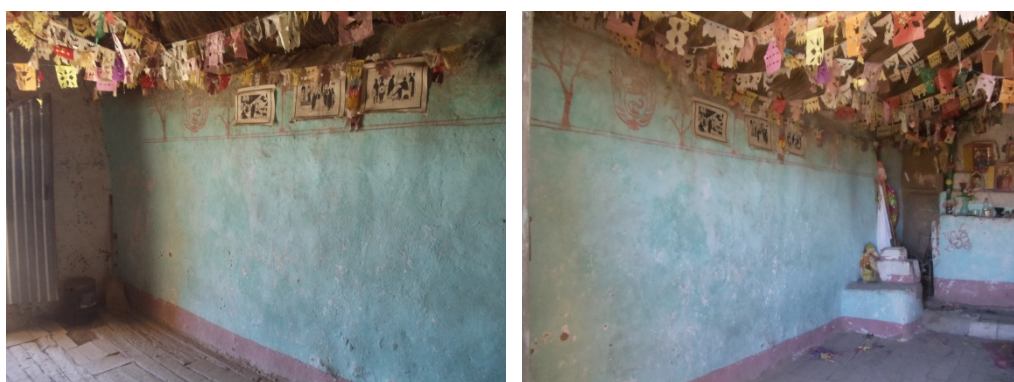
Vistas internas del muro lateral derecho (evangelio)
