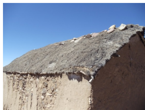
Vista externa del estado actual de la techumbre.
