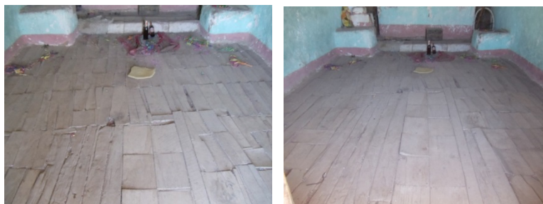
Vistas del entablonado de madera en la superficie de la nave principal.
