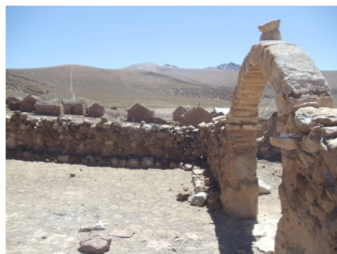
Vista en perspectiva, se aprecian las jambas que soportan el arco superior.
