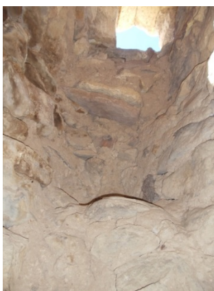
Vista interna de los muros de la torre.
