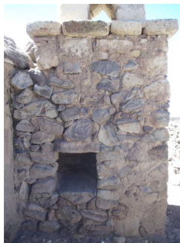
Vista posterior de estado actual de los muros del primer cuerpo de la torre, donde se tiene la abertura de ingreso a ella.
