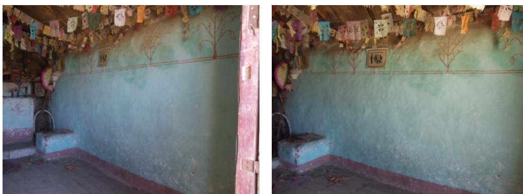
Vistas internas del muro lateral izquierdo (epístola)
