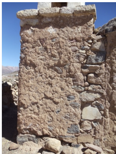
Vista frontal de estado actual del muro del primer cuerpo de la torre.
