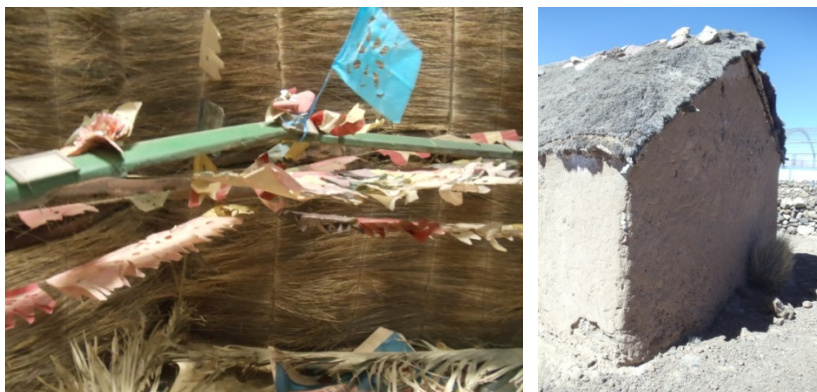
Vista interna y externa de la techumbre sobre el presbiterio.
