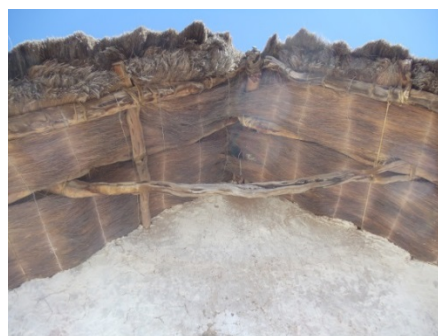
Vista interna de la techumbre donde el ichu se conserva en buen estado. Se ve el sistema constructivo de par y nudillo con los troncos de queñua.
