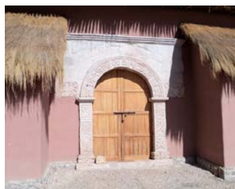
Portada de piedra lateral consolidada.
