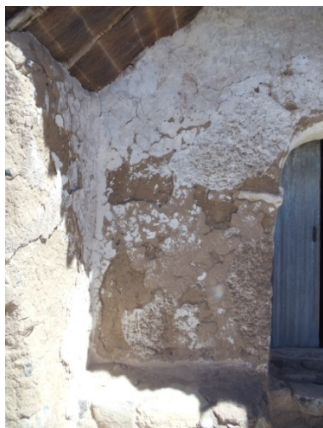
Vista del muro frontal donde se observa el desprendimiento del revoque de barro y deterioro de la capa de yeso.
