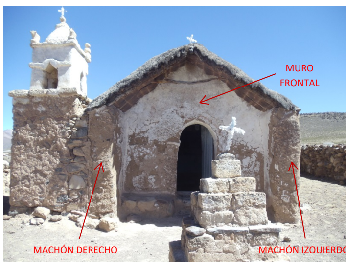
Vista frontal de la fachada donde se ubica el arco cobijo, se muestran los muros que definen este espacio.
