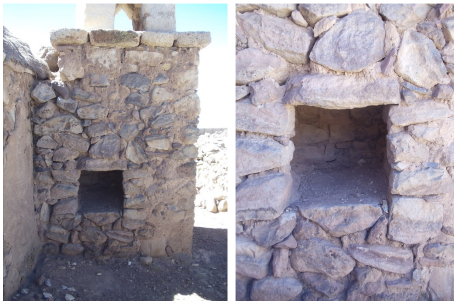
Vistas en la que se observa el piso interior de la torre.
