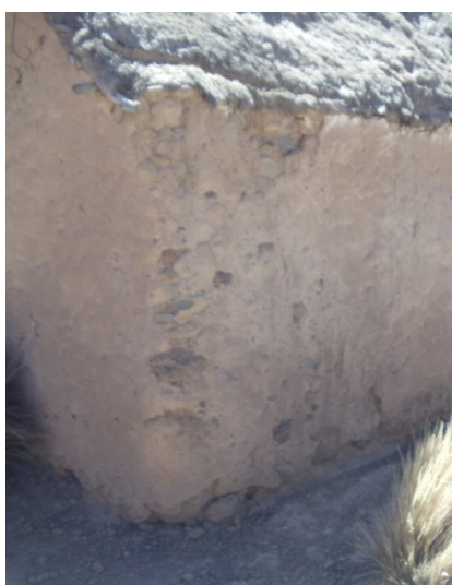
Vista externa de estado actual del muro lateral derecho (evangelio) donde se ubica el presbiterio.
