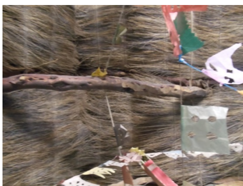
Vista interna de la estructura de la techumbre.
