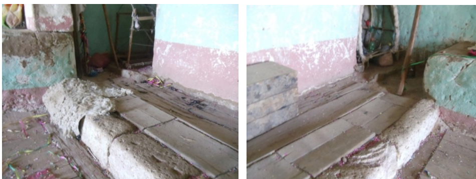
Vistas del entablonado de madera en la superficie del presbiterio.
