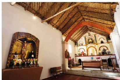
Vista interna de la nave ya restaurada.
