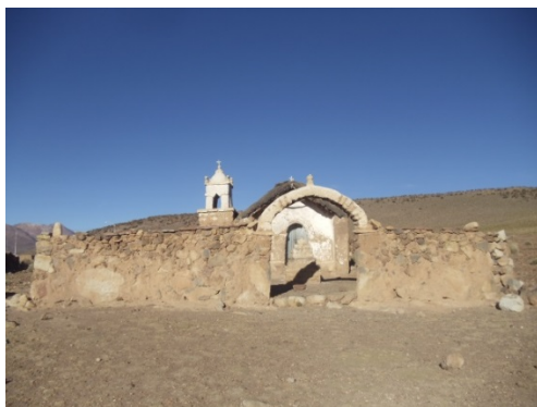
Noviembre 2015: Vista frontal del cerco perimétrico donde se observa el revoque de barro en buen estado.
