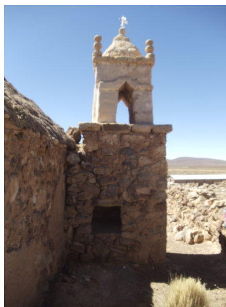
Vista posterior de la torre - campanario
