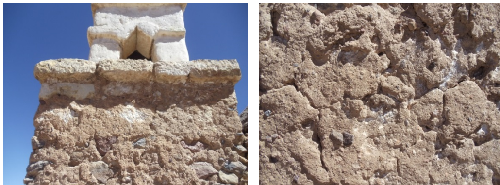
Vistas a de talle de algunas zonas en la que se vislumbra el acabado de yeso que poseía.
