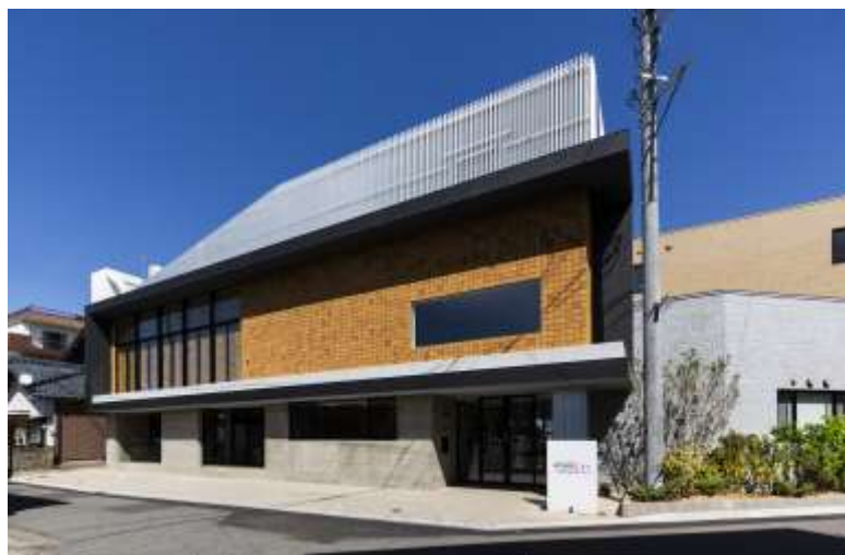
Figura 43: Fachada del Fukuikamogakuen Angel Kindergarten. Fuente: Autor, Fecha: (ArchDaily, 2020)
