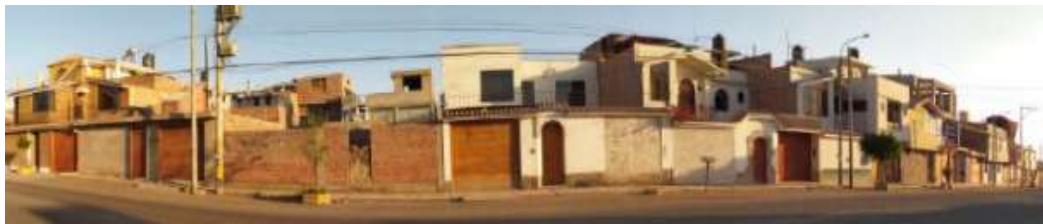
Perfil frente al terreno – En su mayoría son viviendas consolidadas de dos pisos.
