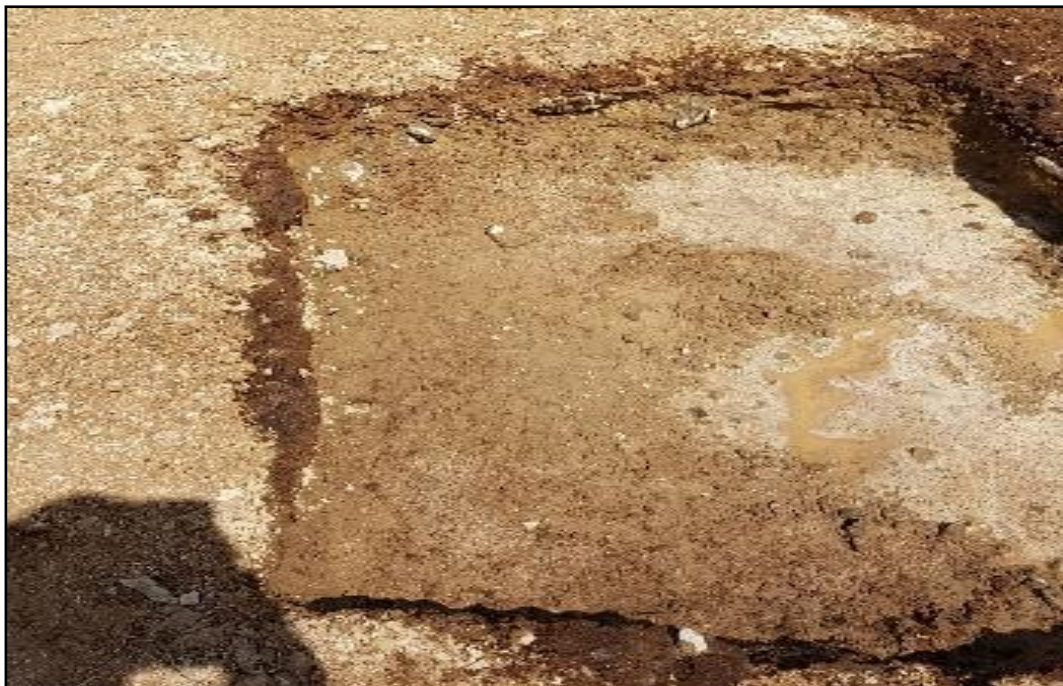
Fotografía N°C3. Poza de 1.3m*1.5m*0.25m antes de ser perfilada manualmente.
