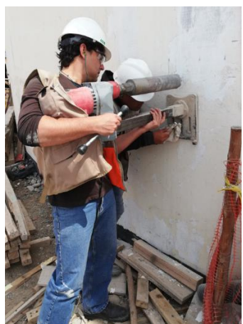
Figura 16. Colocación de equipo de Diamantina.
