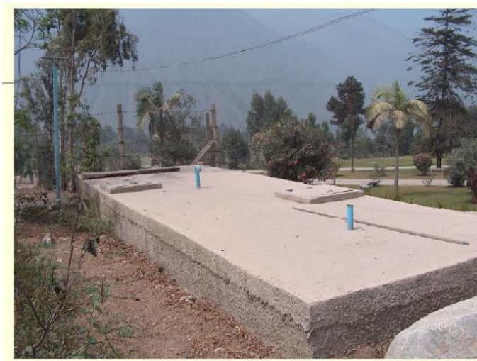
Figura 1. Reservorio Semi Enterrado.
