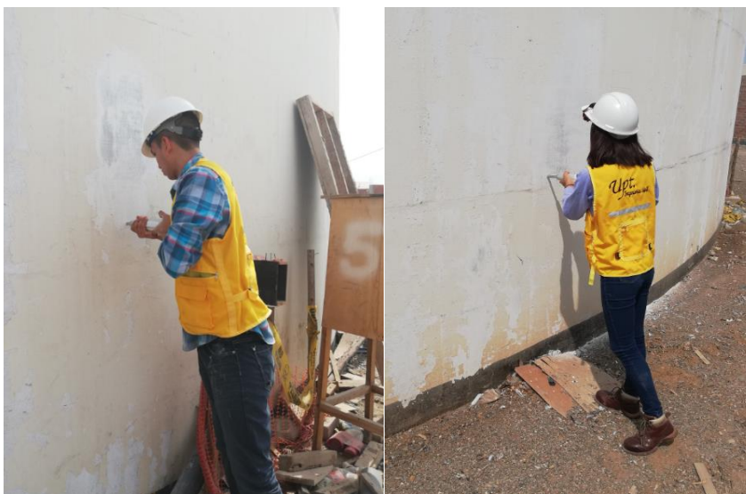
Figura 13. Ensayo con esclerómetro en el Reservorio R-15.
