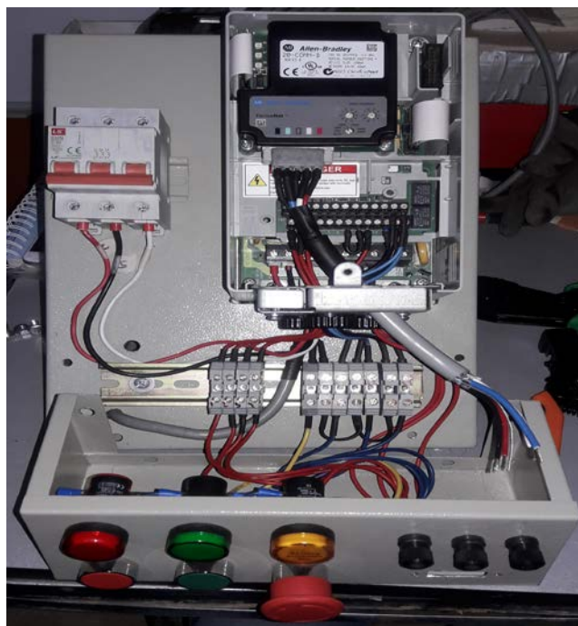
Figura 80: Reacondicionamiento del cableado del módulo (Fuente propia)
