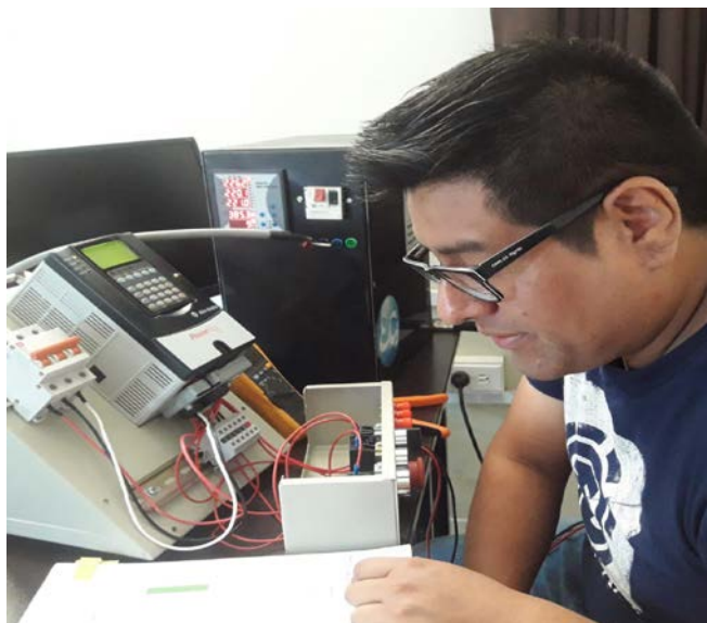
Figura 79: Ingreso de parámetros al variador (Fuente propia)
