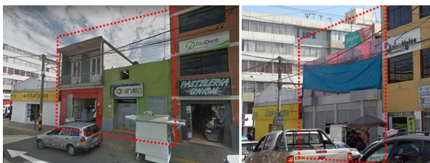
Figura 236. Av. San Martín N° 812 – 814, caso de demolición y reconstrucción. Fuente: Elaboración propia
