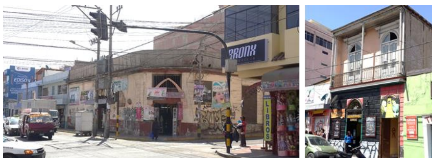
Figura 237. Izq. Av. Patricio Meléndez N° 215. Der. Av. San Martín N° 831. Caso de desafortunadas “mejoras”. Fuente: Elaboración propia.
