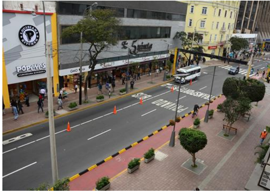
Figura 25. Av. Larco, obra de remodelación concluida. Fuente: Web Municipalidad de Miraflores.
