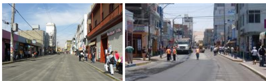
Figura 66. Trabajos de recapeo y pintado de la Av. Patricio Meléndez. Fuente: Web MPT.
