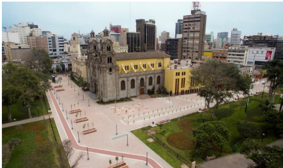
Figura 27. Obra concluida de Estacionamientos subterráneos sobre calle Lima y Virgen Milagrosa. Fuente: Web Municipalidad de Miraflores.
