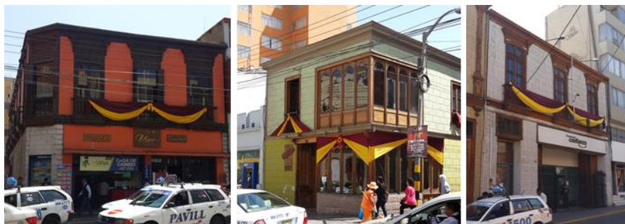
Figura 238. De izquierda a derecha: Av. San Martín N° 606, 596 y 788, buen ejemplo de uso y mantenimiento. Fuente: Elaboración propia.
