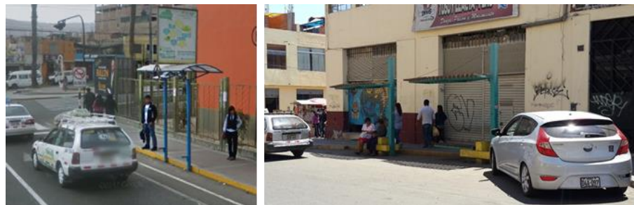
Figura 260. Paraderos de transporte público a nivel de pista en conflicto con transporte vehicular. Izq. Ca. Gral. Vizquerra. Der. Av. 2 de Mayo. Fuente: Estudio de Observación Marzo 2017, Elaboración Propia.
