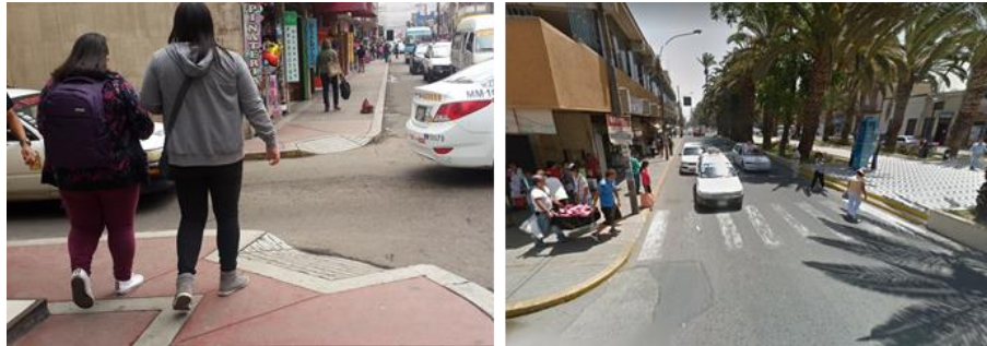
Figura 249. Izq. Ca. Bolívar. Der. Av. Bolognesi. Rampas con orientación diagonal y sin ritmo en la senda peatonal. Fuente: Estudio de Observación Marzo 2017, Elaboración Propia.
