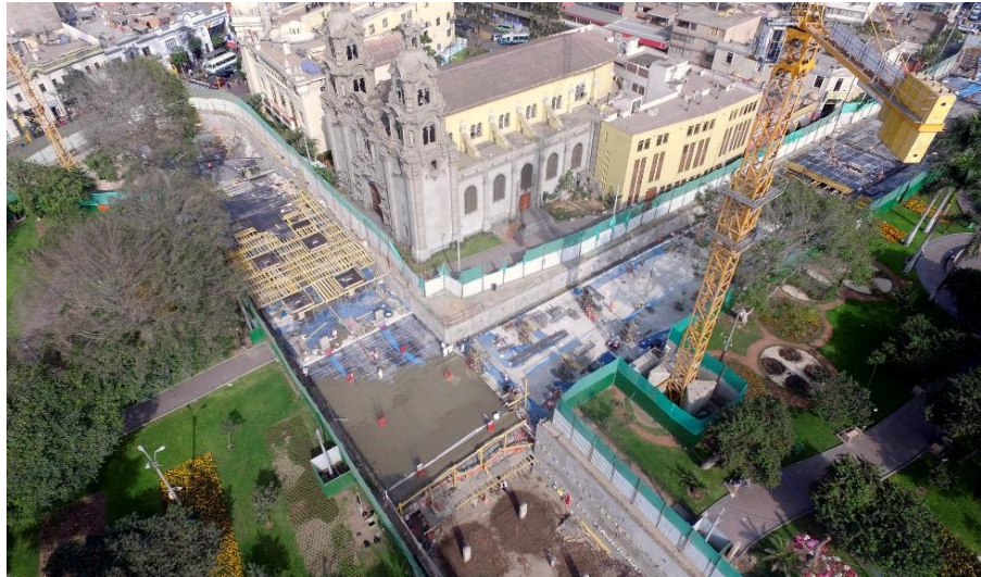
Figura 26. Etapa de construcción de los estacionamientos subterráneos sobre calle Lima y Virgen Milagrosa. Fuente: Web Municipalidad de Miraflores.
