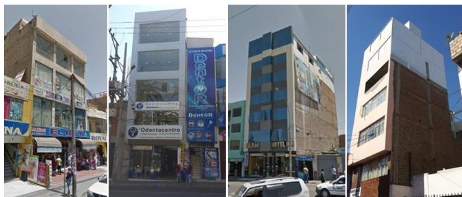
Figura 228. De izquierda a derecha: 02 galerías con niveles superiores vacíos, hotel y hospedaje con estructuras ligeras inseguras. Fuente: Elaboración Propia.
