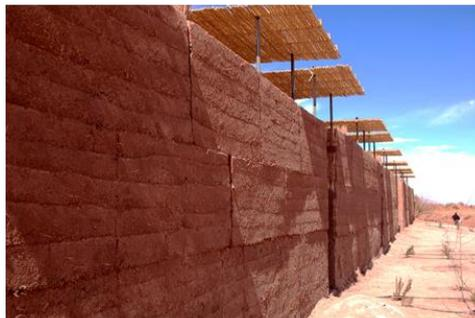
Muros exteriores con materiales rudimentarios de la zona como es un sistema estructural de tapial y cobertura livianas de esterillas.
