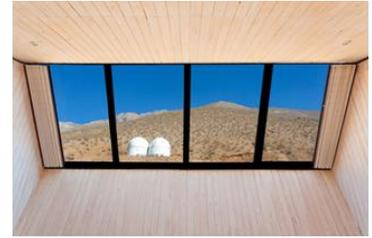
1 Zona de alojamiento: Estructura y enchapes de madera en muros, piso y graderías de madera y vidrio templado en ventanas, cubierto por persianas. (Pastorelli, G. 2012).
