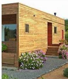
Aplicación de Madera machimbrada en exterior
